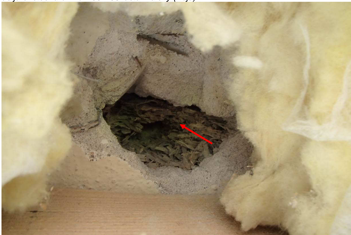
Kuva 11. Ulokkeen alapinnan alkuperäisenä lämmöneristeenä on lastuvillalevy (Toja).
