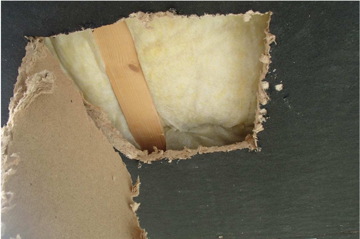
Kuva 8. Rakenneavaus ulokkeen alapinnasta: tuulensuojalevy ja koolaus/eristys.
