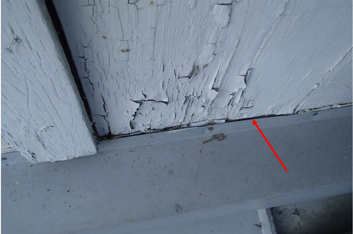
Kuva 24. Yläikkunoiden puumateriaalissa ja maalipinnoissa havaittiin ikääntymistä sekä vesipellityksen ja ikkunarakenteen välissä havaittiin rakoja.
