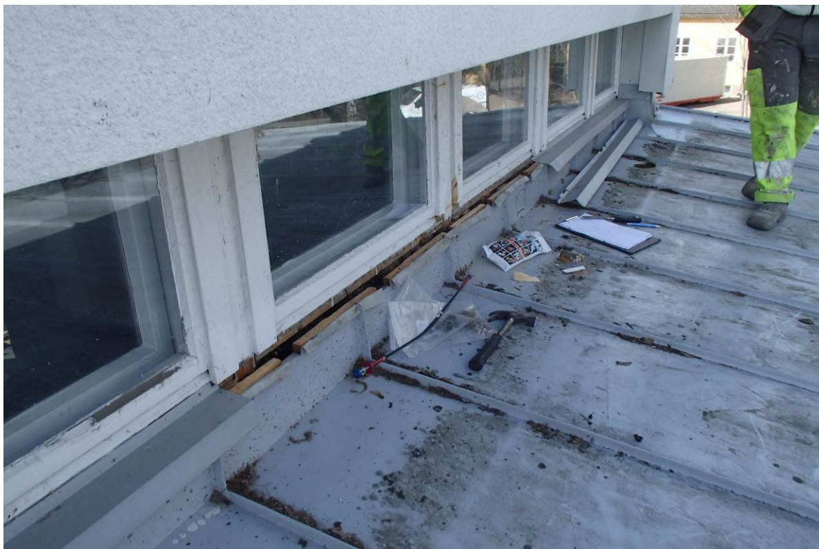
Kuva 14. Luokkahuoneen yläikkunan alaosan rakenneavaus.
