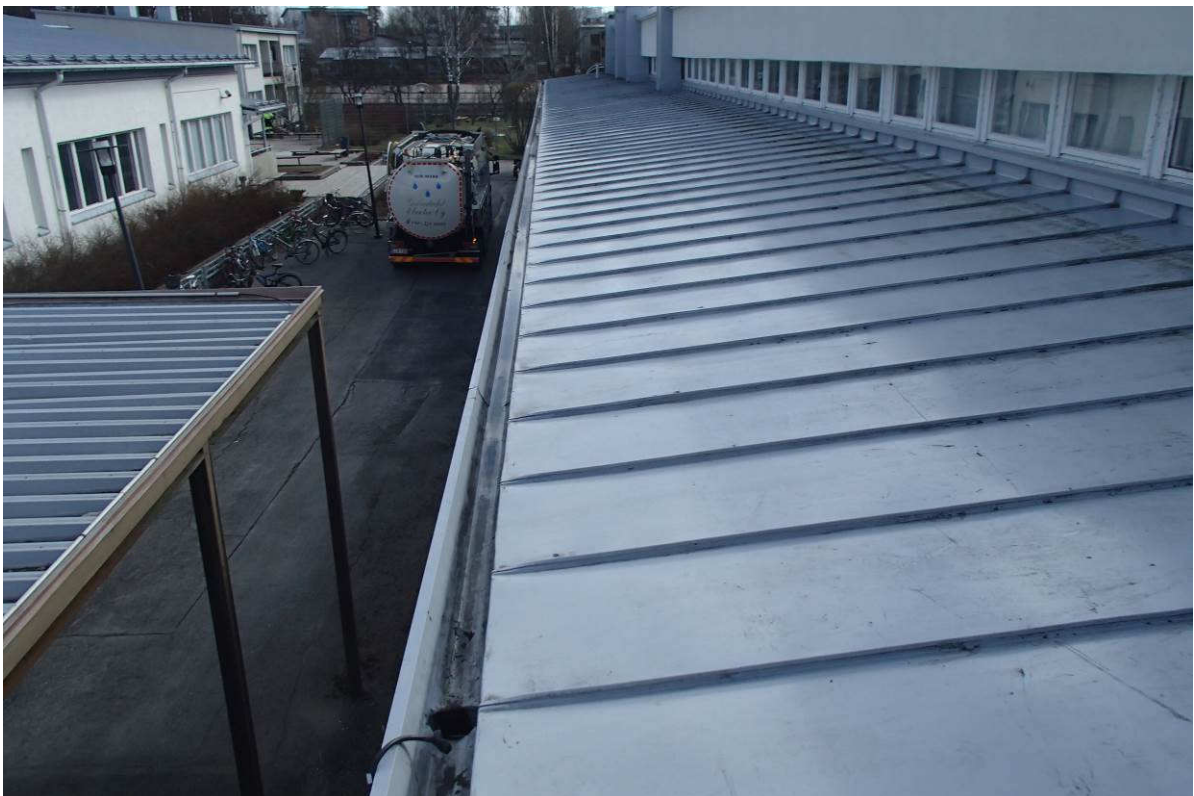
Kuva 39. Yleiskuva pohjoiseen kaatavalta vesikatolta.
