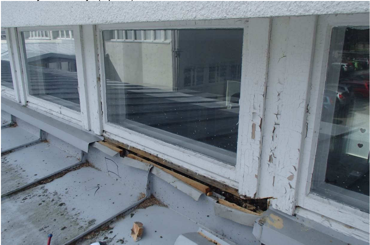
Kuva 13. Luokkahuoneen yläikkunan alaosan rakenneavaus.
