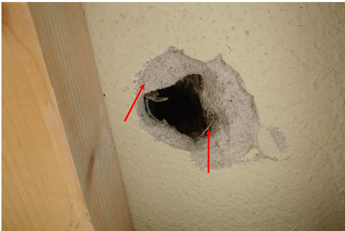
Kuva 10. Ulokkeen alapinnan alkuperäiset rakenteet ovat rappausverkolla vahvistettu rappaus ja eristeenä on noin 90...95 lastuvillalevy (Toja).
