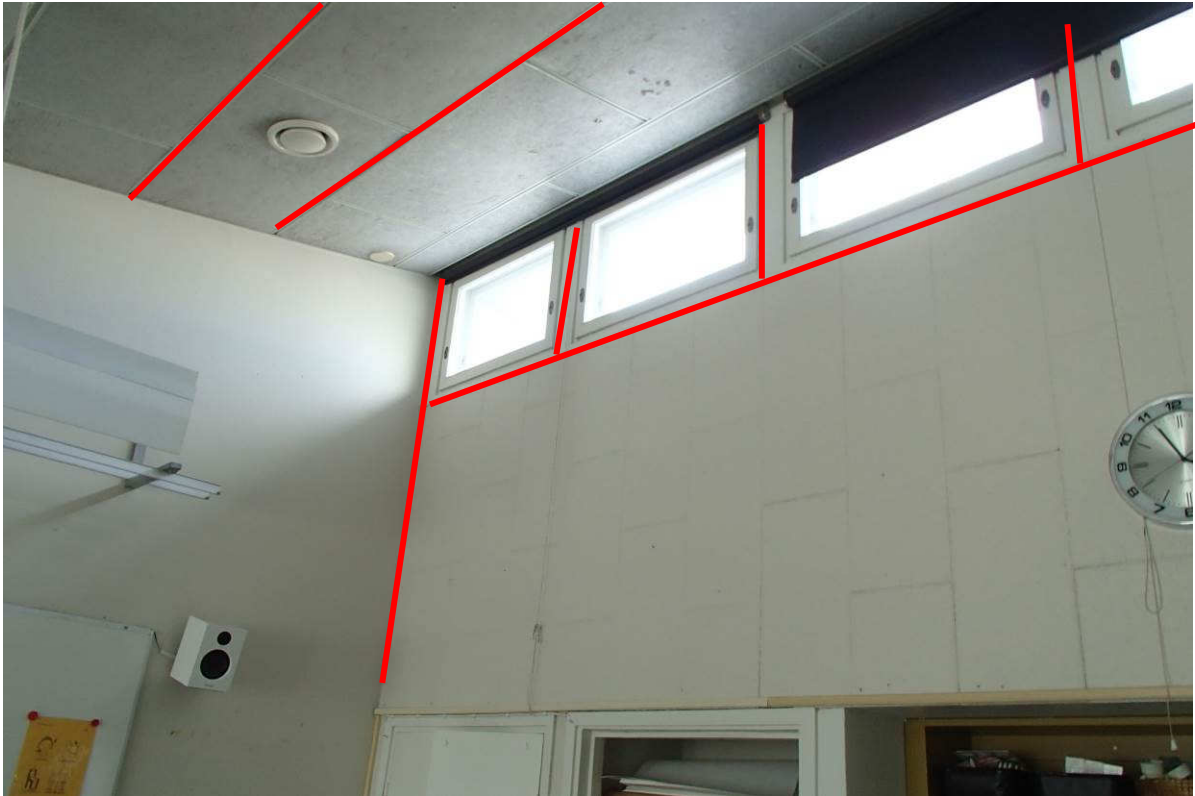
Kuva 60. Rakenneliitosten ilmavuotokohdat.
