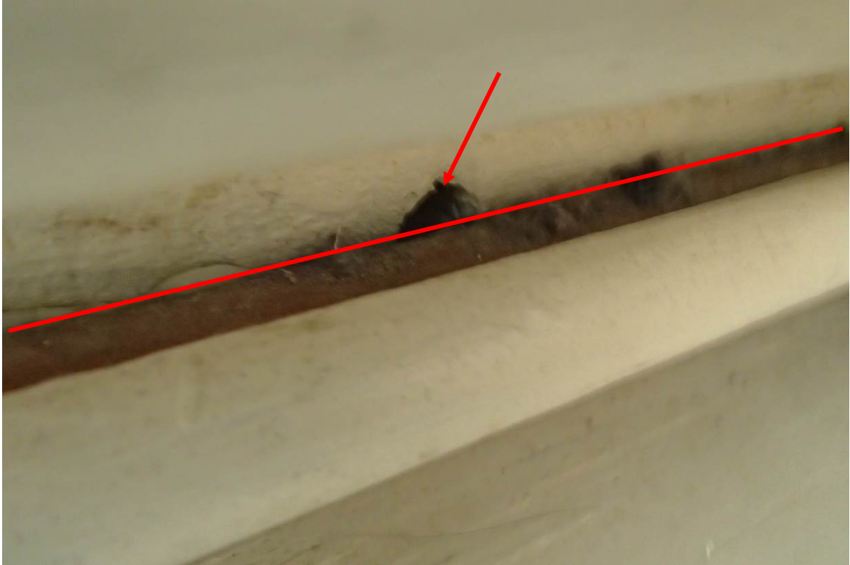
Kuva 62. Rakenneliitosten ilmavuotokohdat.
