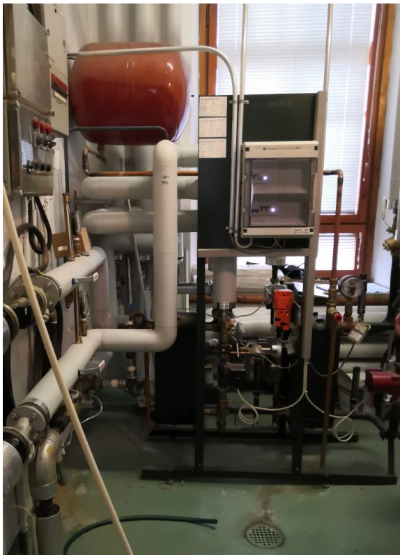
Kuva 5. Lämmönjakokeskus.
