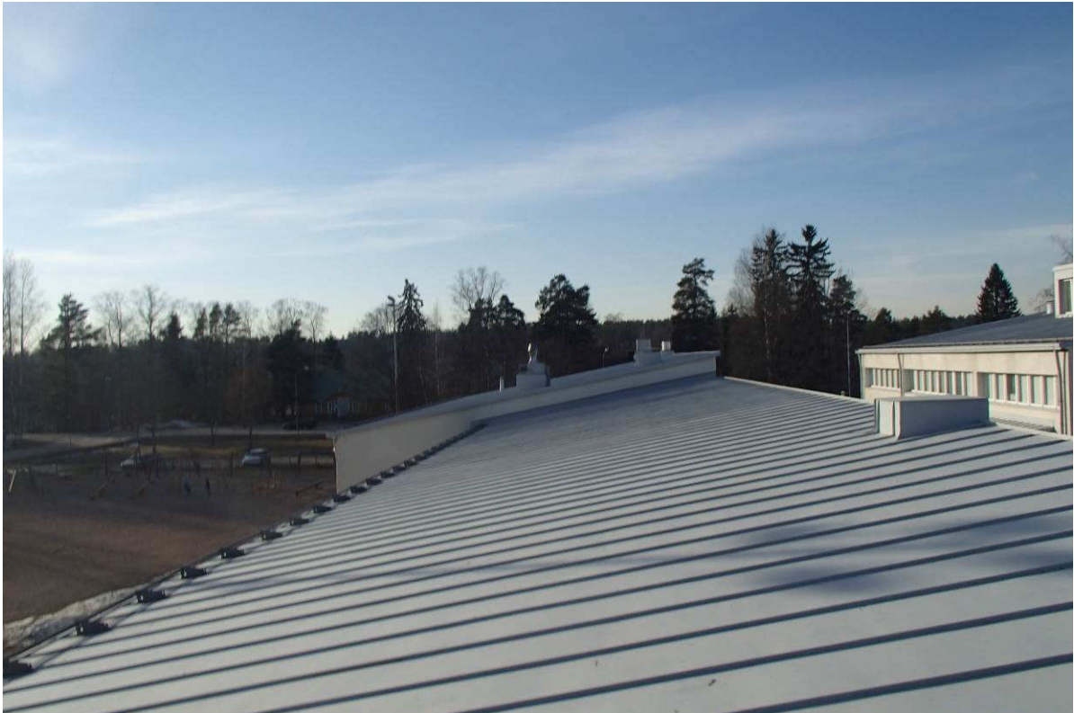
Kuva 38. Yleiskuva etelään kaatavalta vesikatolta.
