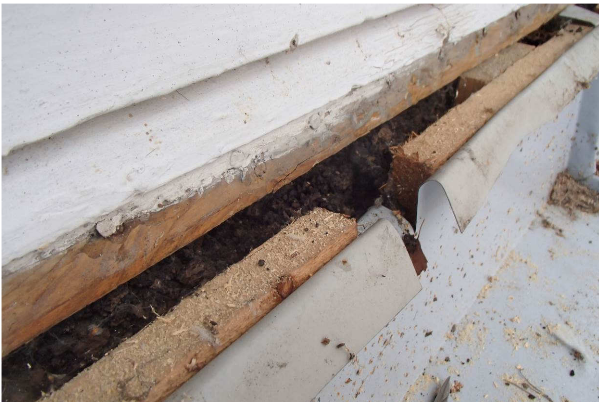
Kuva 16. Yläikkunan alaosan rakenneavaus.
