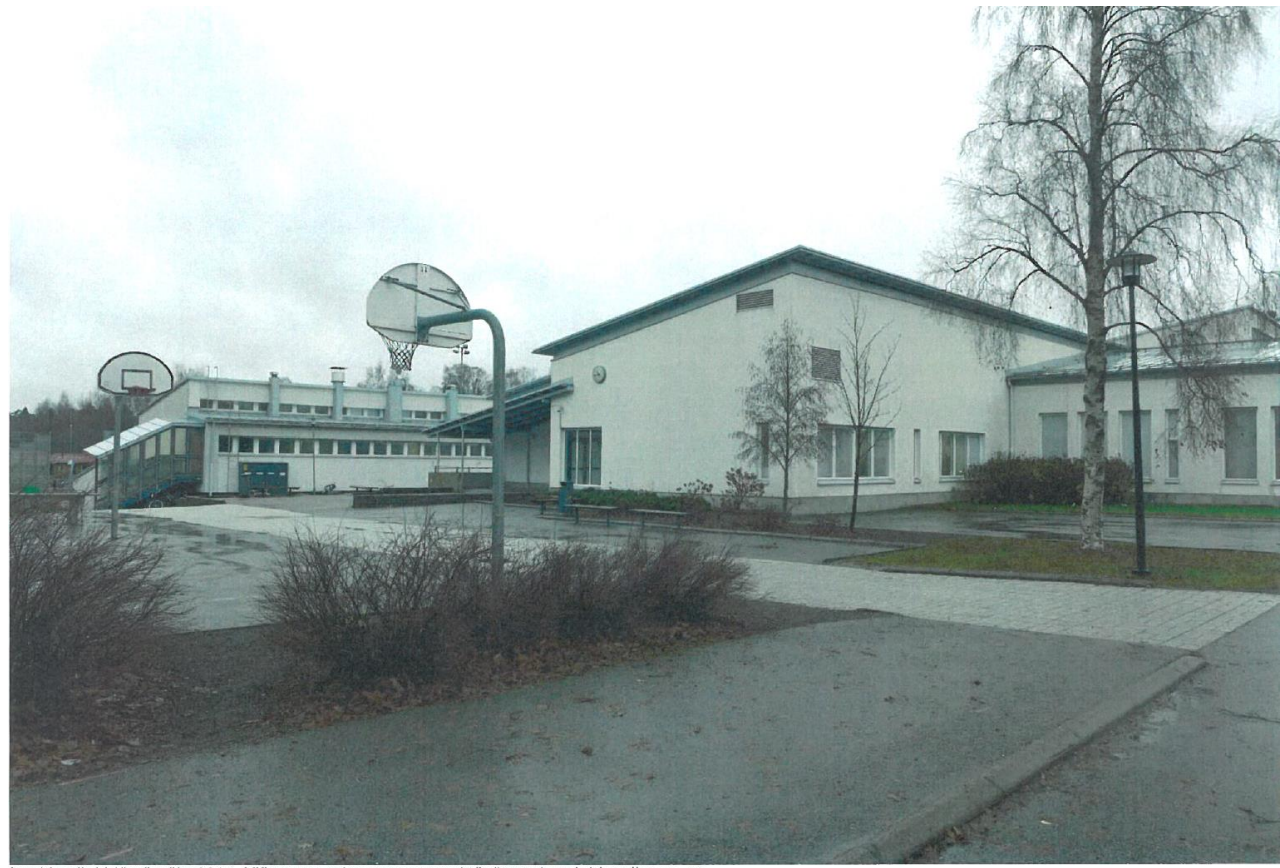
Luokkasiipi idästä päin 2014. Yläasteen rakennusosat peittävät vanhan juhlasaliosan. LA
