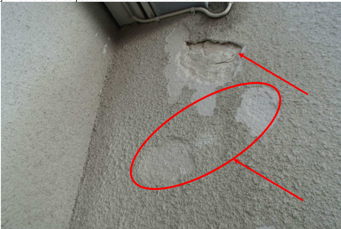
Kuva 31. Julkisivujen rappausvaurioita.
