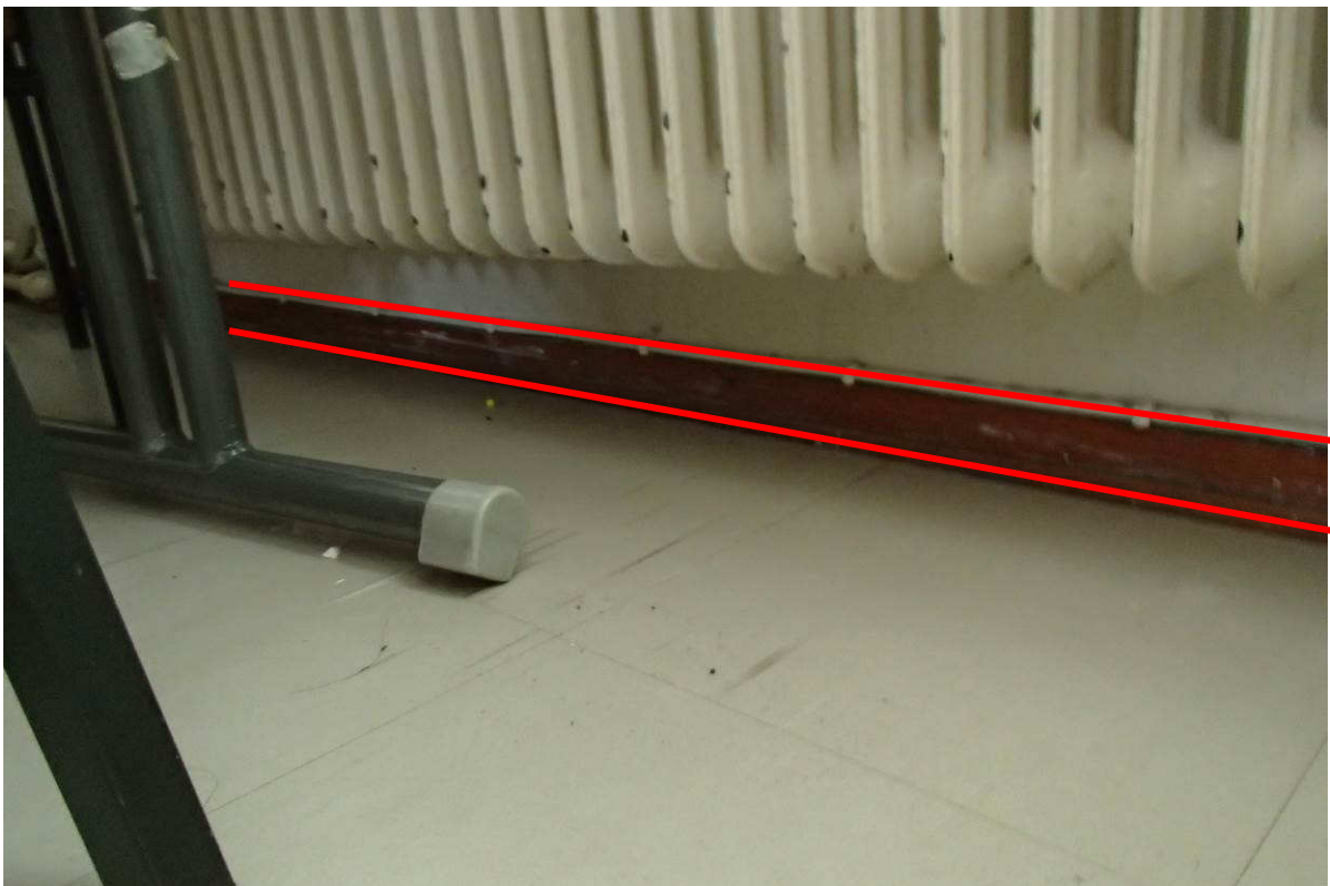
Kuva 61. Rakenneliitosten ilmavuotokohdat.
